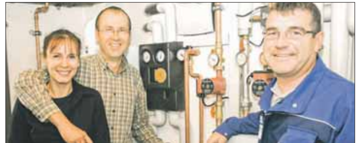
Die Heizung mit Gasbrennwerttechnik hat Manfred Hobmaier im Keller von Birgit Engl und Jürgen Sandner eingebaut. Foto: Chiemgauer
